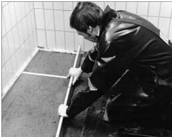
4. Postaviti vođice na intervalima od 2-3 metra, ili na svaku drugu udaljenost koja je odgovarajuća u odnosu na površinu polaganja. Malter je potrebno nivelisati na odgovarajuću visinu na osnovu vođica.
