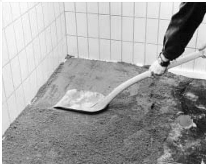
3. Rasprostrti malter i pažljivo ga sabiti. Ne rasprostirati više maltera nego što je potrebno za 4-5 redova pločica u jednom prelazu.
