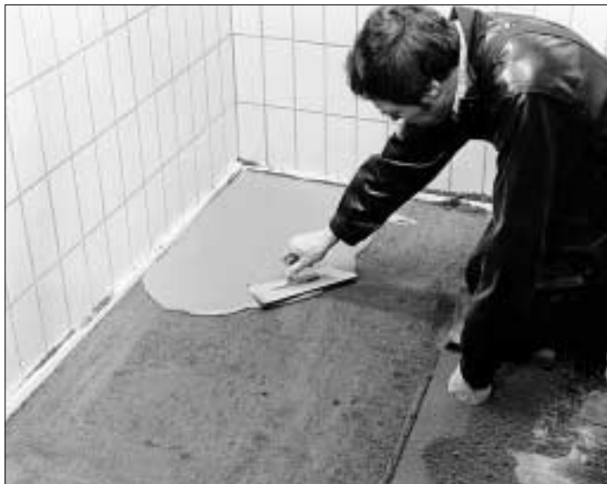
5. Tečno cementno mleko (cement i voda) je potrebno razliti preko cementne košuljice.
