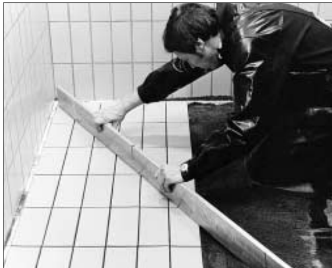
8. Glatkost površine svake novo postavljene sekcije je potrebno pažljivo proveriti libelom i prilagoditi ako je to potrebno.
