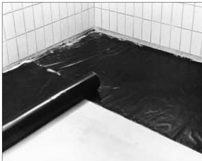
2. Plastičnu foliju, 0.1 mm debljine je potrebno razrolati po podlozi. Uz pomoć meke četke potrebno je izravnati foliju i ukloniti sve mehuriće vazduha. Izvaljati svaku narednu rolnu tako da ona preklapa prethodnu.
